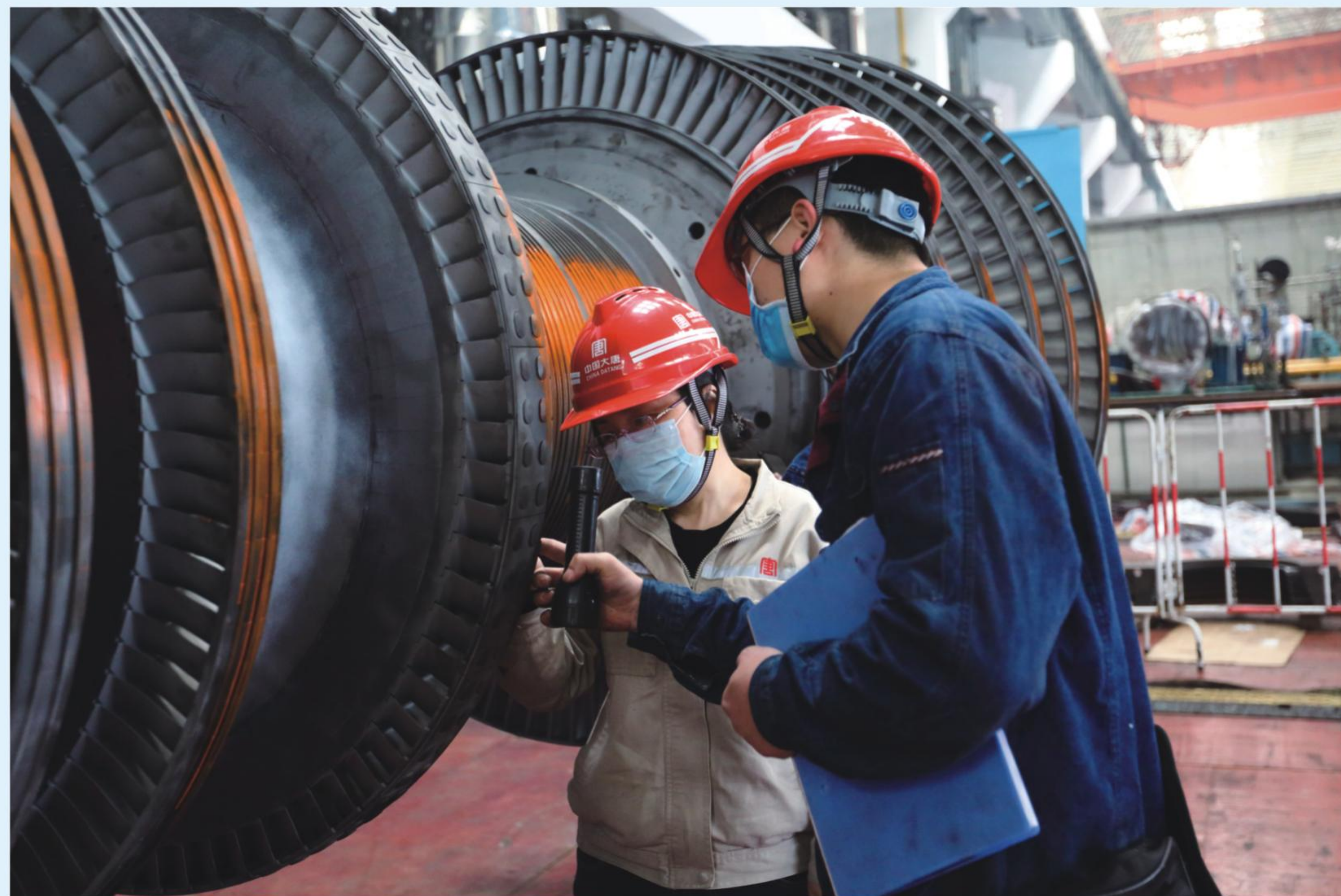
机组检修保安全
