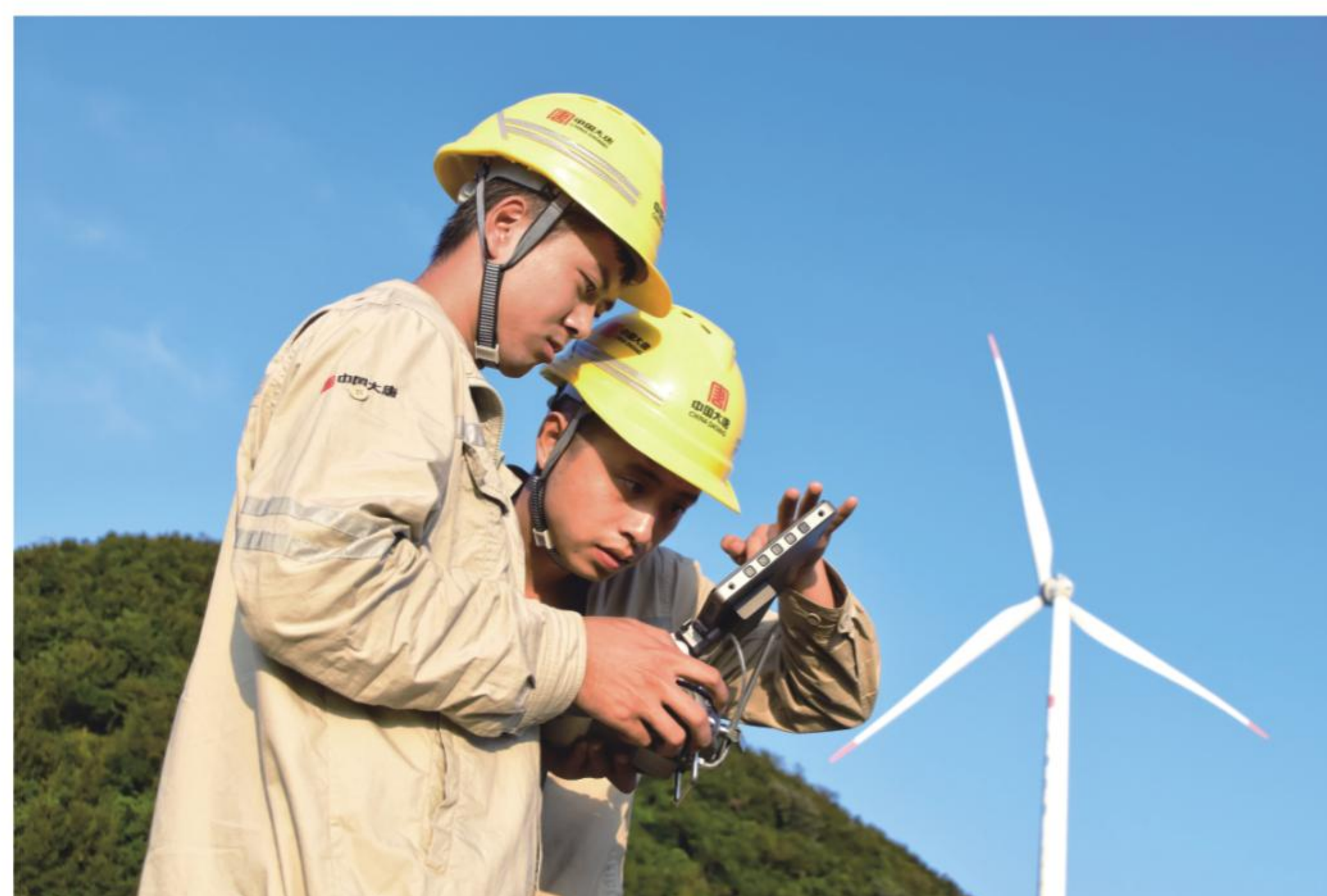
利用无人机进行风机轴承外观检查
